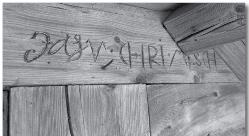
Die Speicher des Schwarzenburgerlandes zeichnen sich durch ihre Originalität und Ursprünglichkeit aus.
